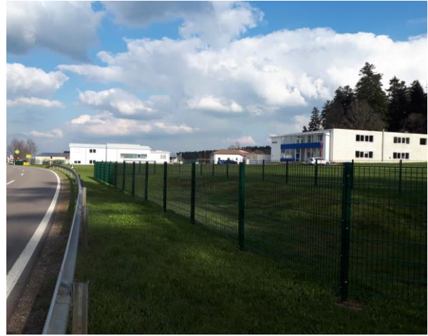
Pforzheimer Straße: Blick Richtung Osten auf das bestehende Gewerbegebiet Schwarzenberg
