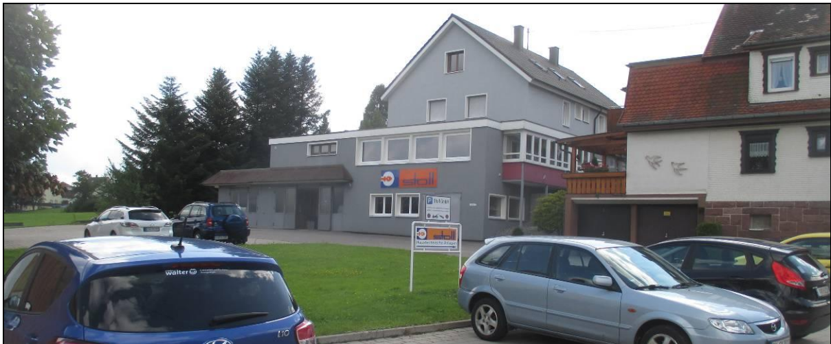
Abbildung 3 Gebäudekomplex Nr. 11 (Bildmitte).
