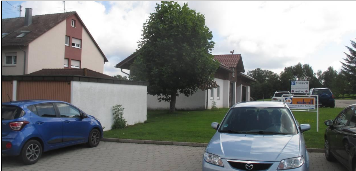
Abbildung 2 Blick von Westen: Fertiggaragen (links), Schuppengebäude Nr. 7 (Hintergrund Mitte).
